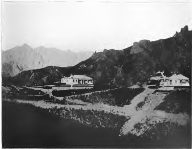
Genesungsheim „Mecklenburghaus“ bei Tsingtau (Kiautschou).
